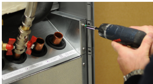
3. Skruva bort kylmodulens fästsruvar.
